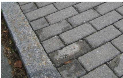
Рис. 3. Желто-коричневые пятна на бетонных изделиях
